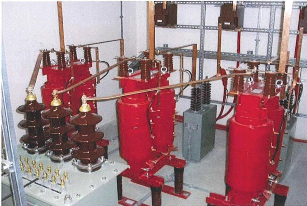
Starre Parallelankopplung - Aufbauvariante mit allen Elementen auf einer Ebene. Für kleinere, aber hohe Räume empfiehlt es sich, die Kondensatoren erhöht anzubringen.
